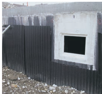
REPLAST «R» horizontal verlegt als Schutz- und Entwässerungsschicht
