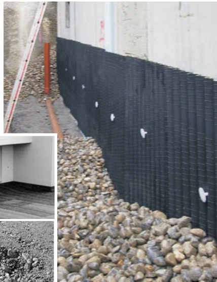
REPLAST «R» horizontal verlegt als Schutz- und Entwässerungsschicht
