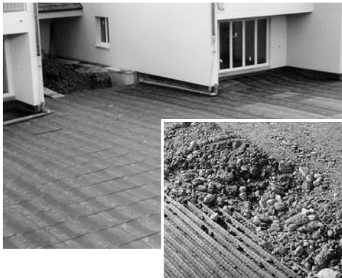
REPLAST «R» horizontal verlegt als Schutz- und Entwässerungsschicht
